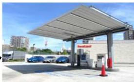
水素ステーションの設置
