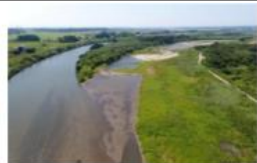
河道掘削後の多様な自然環境の創出（久慈川）
