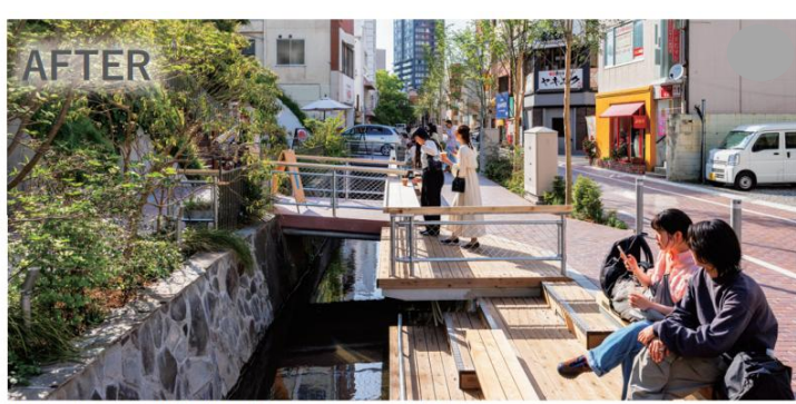
水路に架かる橋の撤去や減幅により水面を最大化 3種類のデッキにより誰もが水辺を享受できる滞留空間を実現
