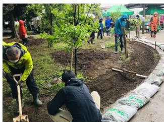
バイオスウェル型雨庭を手づくり施工する様子（上） 世田谷グリーンインフラ学校チラシ（右）
