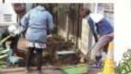
掘った穴に浸透貯留材を深さ15~20cm投入
