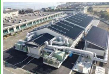
滋賀県高島浄化センター
