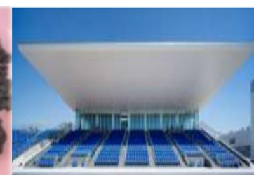
海の森水上競技場(東京都江東区) 出典：再生骨材コンクリート利用工事事例集P15
