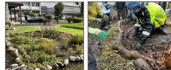
枝葉や土塊、石組みなどを用いて、土壌の保水・浸透能力を向上させる手法。
