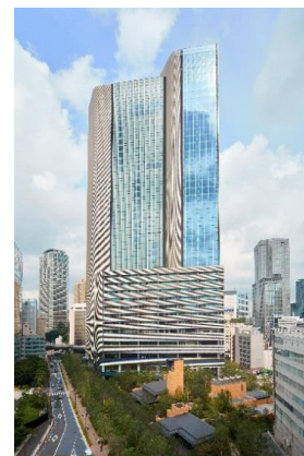
赤坂インターシティAIR 外観
