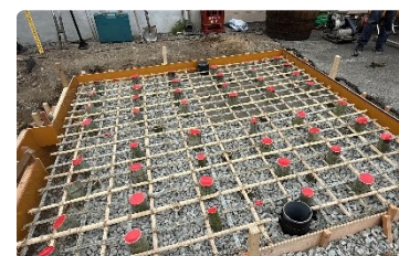
竹筋コンクリート駐車場
