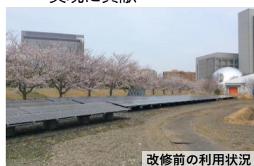
改修前の利用状況
