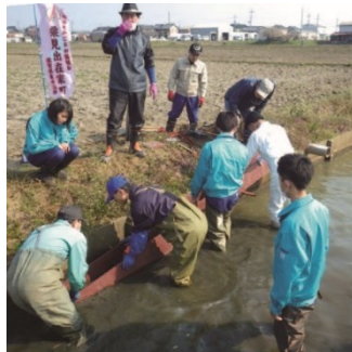
④集落総出で魚道を設置
