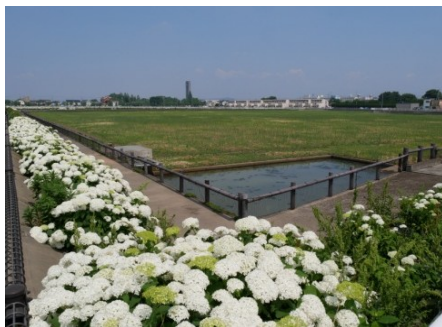
遊水池法面への植栽
