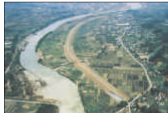
堤防整備後(福島県 梁川町)
