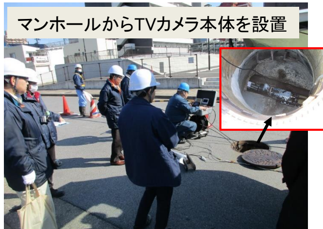
同システムで下水道の取付管を調査
