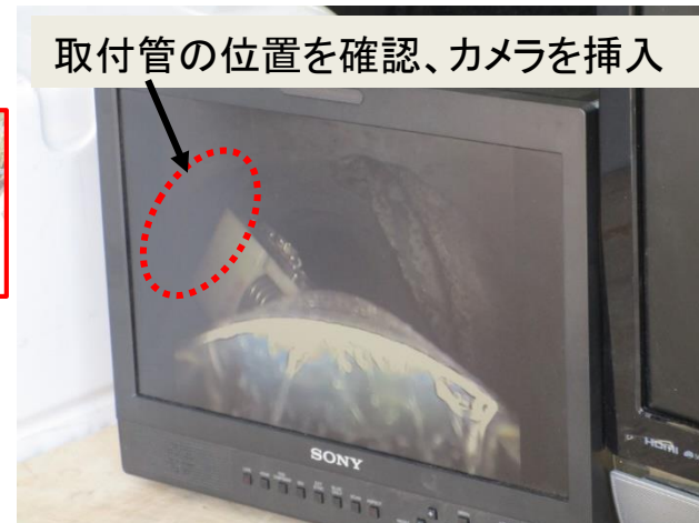
同システムで取付管内部を確認
