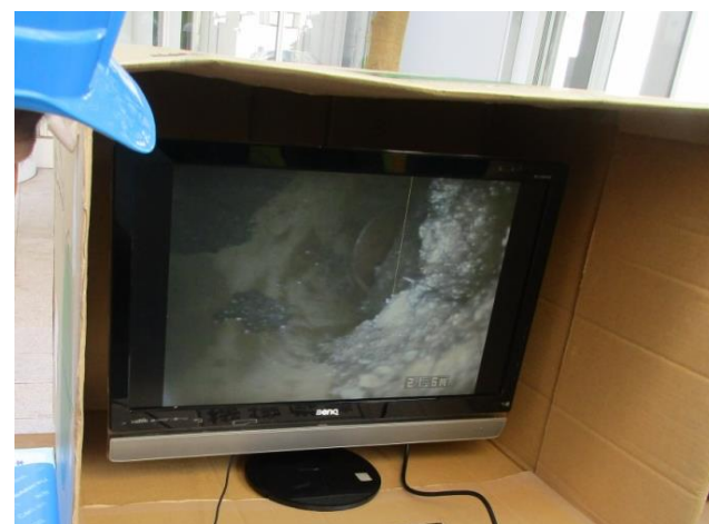
同システムで取付管内部を確認
