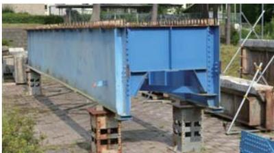
合成桁の構造
