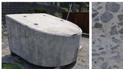
RC 橋脚張出部のアルカリ骨材反応
