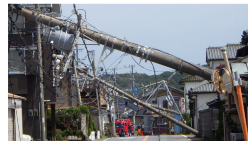
台風により倒壊した電柱
