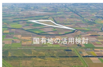
国有地を活用した貯留施設
