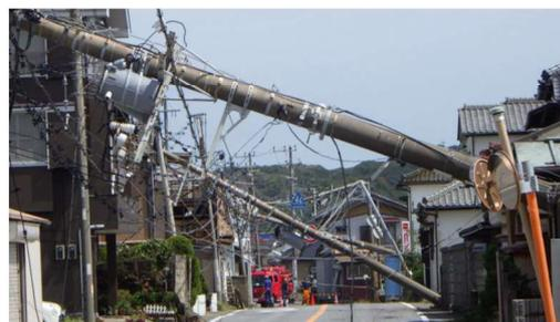
台風により倒壊した電柱
