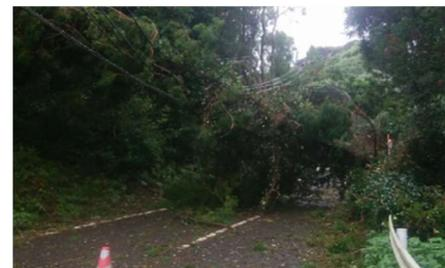
倒木による断線及び道路閉塞
