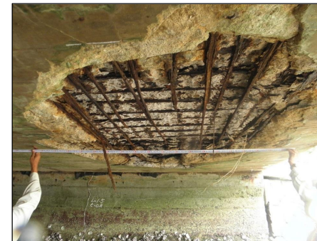
内部の鉄筋が露出した橋梁
