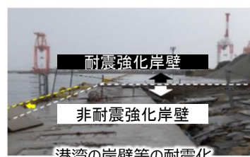
港湾の岸壁等の耐震化
