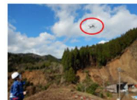
ドローンによる被災状況調査
