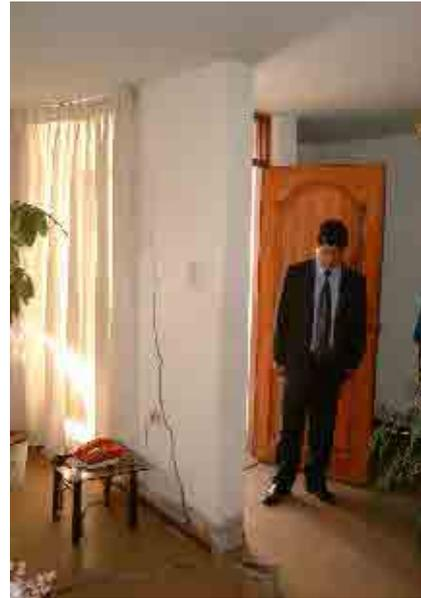
図 5.3.7 液状化により大きなひび割れが発生した壁・床
