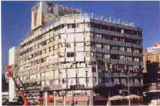
図 4.1.4 中間層破壊<sup>4.3)</sup>
