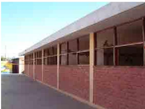
図 5.3.1 RC 造ラーメンにれんが造壁（非構造壁）が挿入された建物
