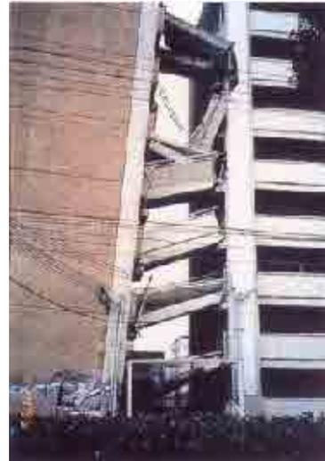
図 4.1.7 1層部層崩壊による渡り廊下の落下<sup>4.3)</sup>
