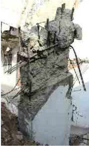
図 5.2.14 扁平な柱断面
