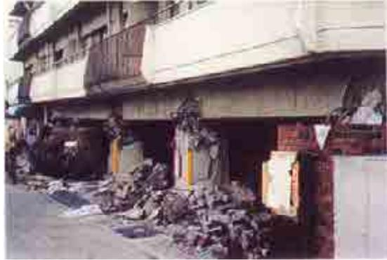
図 4.1.9 ピロティ柱の被害 (2) <sup>4.3)</sup>
