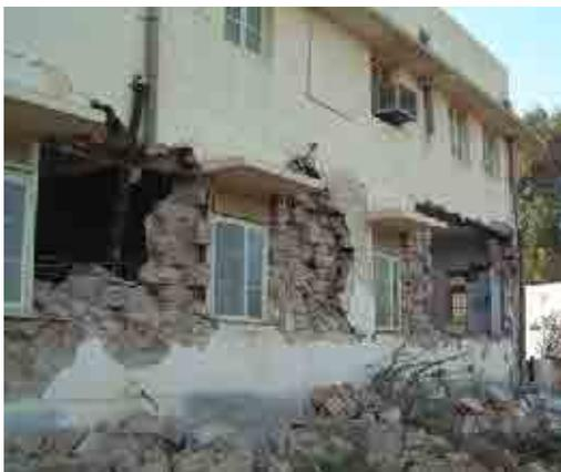
図 5.2.10 損傷した無補強組積造
