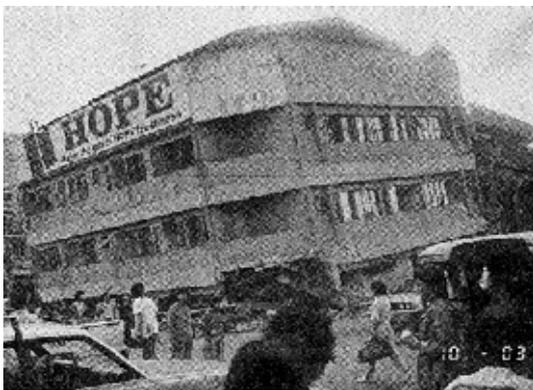
図 5.1.7 1、2階が落階した建物<sup>5.1)</sup>
