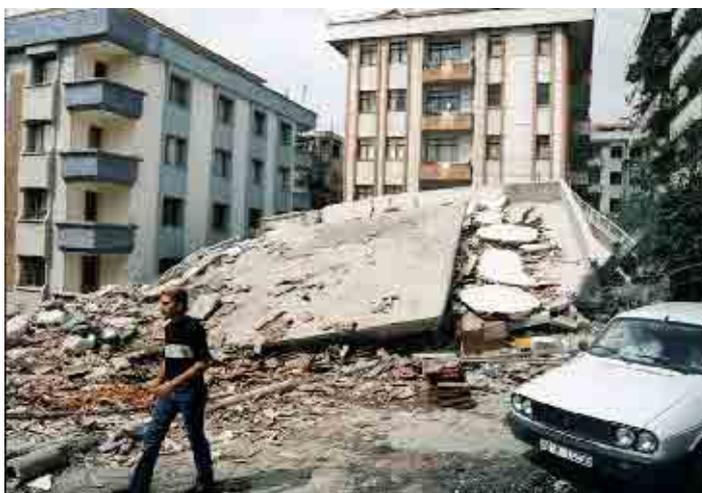
図 4.2.7 パンケーキ破壊した建物
