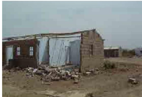
図 5.2.9 面外に倒壊した組積造建物の壁
