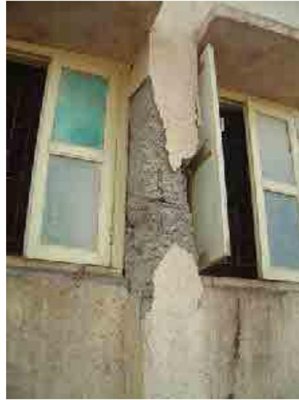
図 5.2.15 短柱化した柱のせん断破壊
