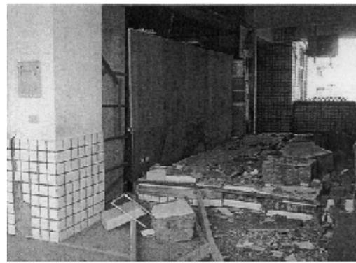
図 4.3.8 れんが造壁の被害<sup>4.5)</sup>
