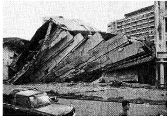
図 5.1.6 パンケーキ破壊した建物<sup>5.1)</sup>
