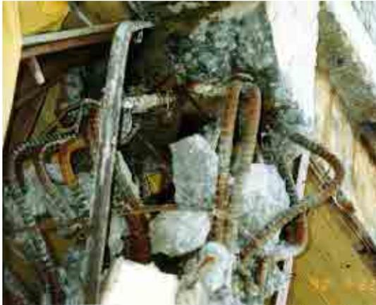
図 5.1.10 柱主筋の座屈
