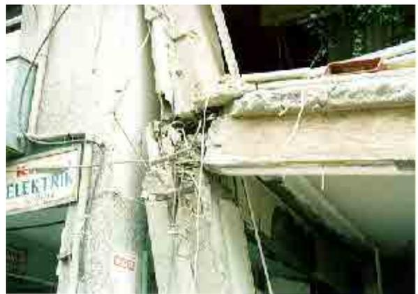
図 4.2.10 柱・梁接合部の破壊
