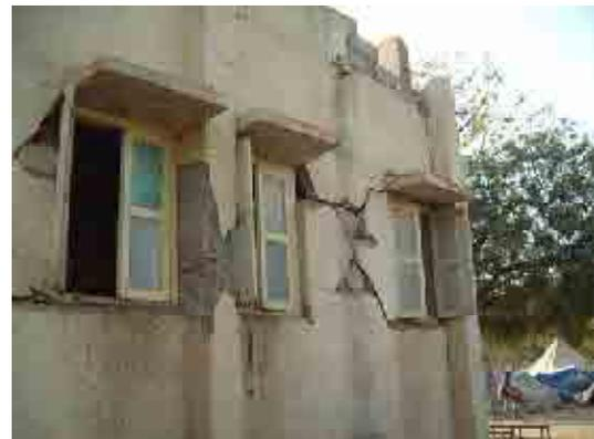
図 5.2.11 柱が鉄筋コンクリート造で壁が組積造の建物の被害
