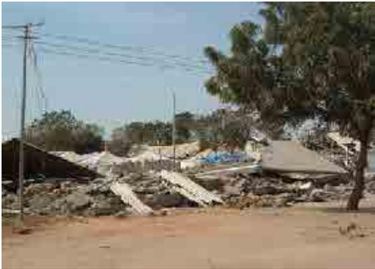
図 5.2.8 低層住宅（組積造）の崩壊
