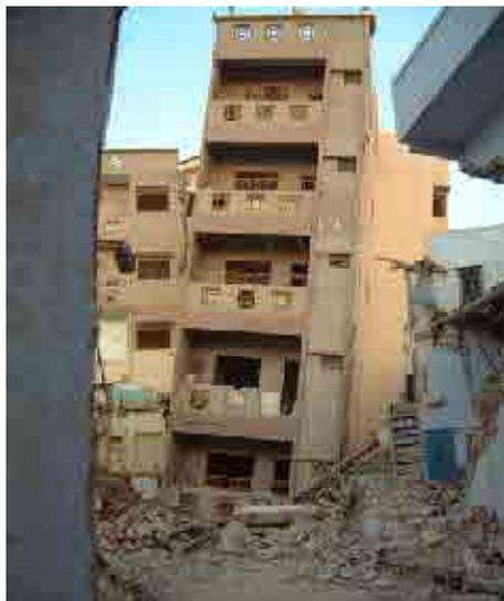
図 5.2.12 1階が崩壊した6階建RC造建物
