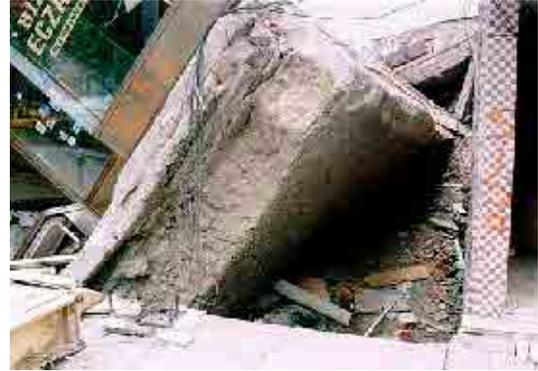
図 4.2.8 地盤の液状化により転倒した鉄筋コンクリート建物（直接基礎）
