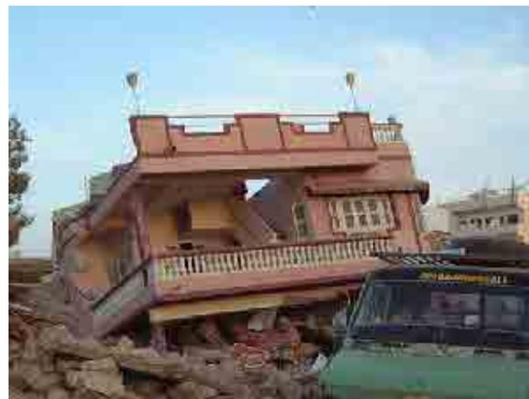
図 5.2.13 伝統的な低層組積造建物の崩壊
