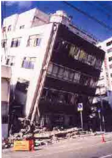
図 4.1.6 6層建物の倒壊<sup>4.3)</sup>
