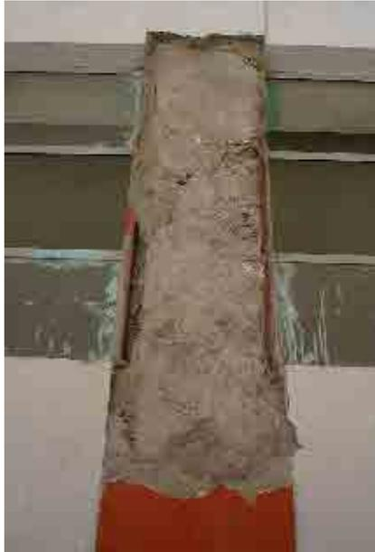
図 5.3.6 付着割裂破壊を生じた柱
