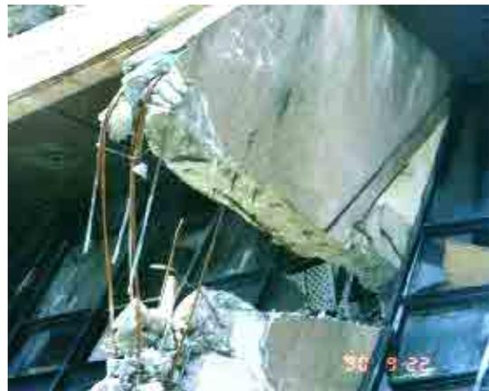
図 5.1.11 1階柱脚部の曲げ引張り
