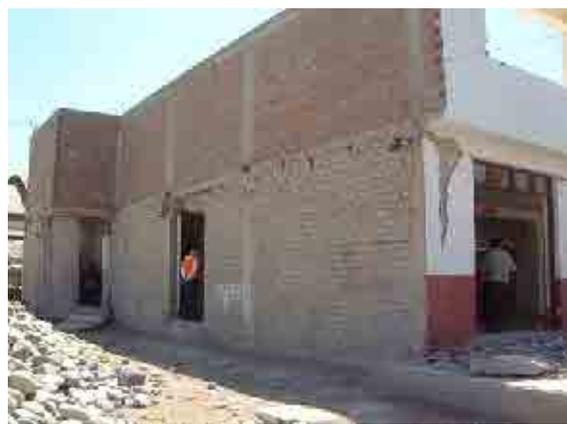
図 5.3.2 枠組み組積造（無筋壁）
