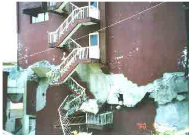
図 5.1.9 下層階が層崩壊した建物
