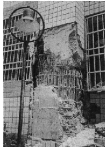
図 4.3.6 れんが造腰壁により短柱化した柱のせん断破壊<sup>4.5)</sup> 図 4.3.7 鉄筋の重ね継ぎ手による柱の被害<sup>4.5)</sup>
