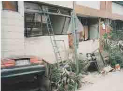
図 4.3.4 1 階が層崩壊した建物
