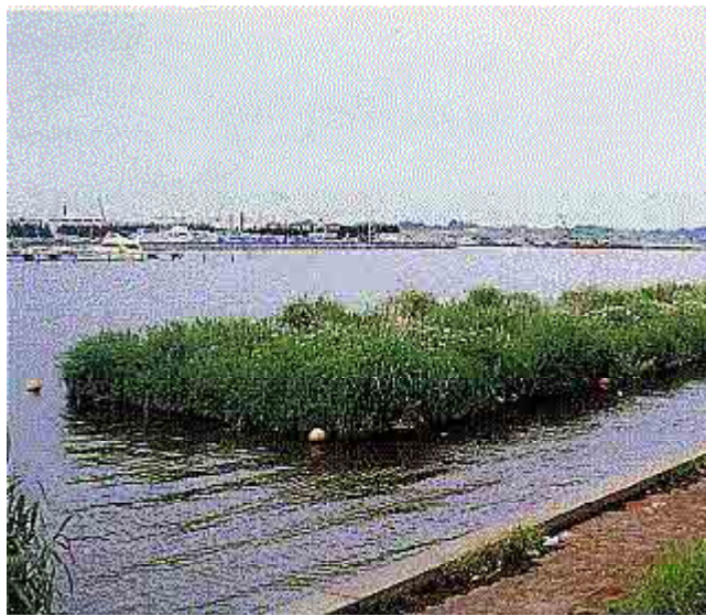
図-13 植生回復浄化施設（浮きヨシ原）土浦港
