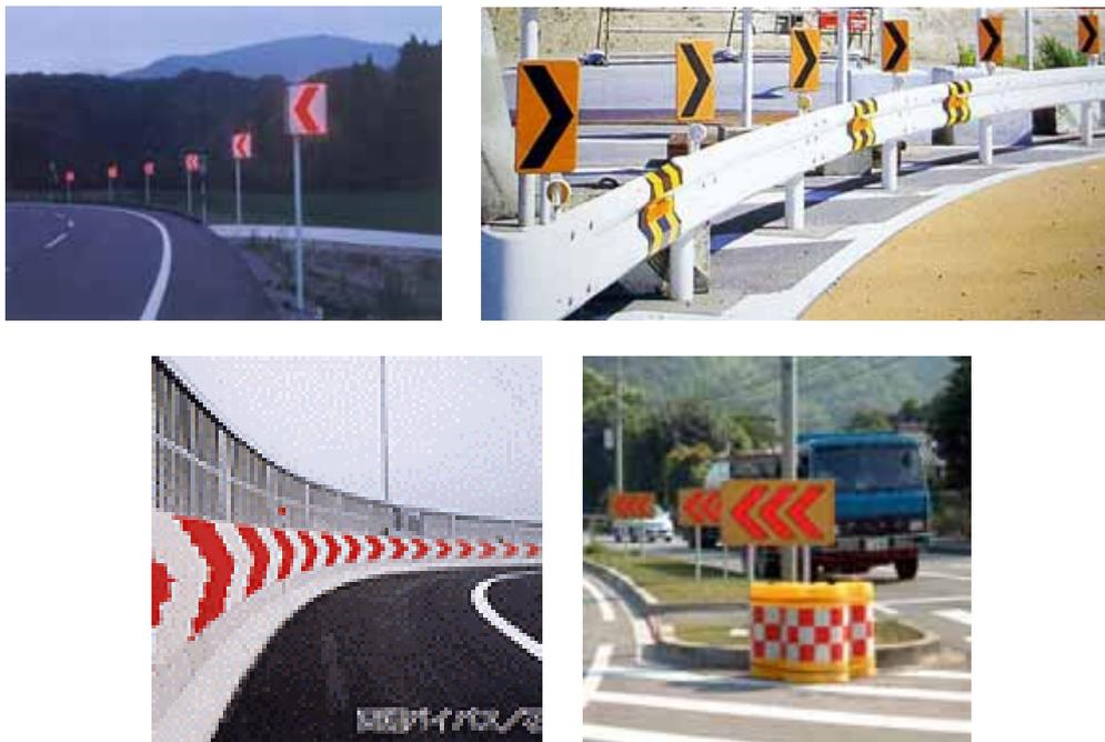
図 7.8.2 視線誘導標の事例(2) [線形誘導標示板]
