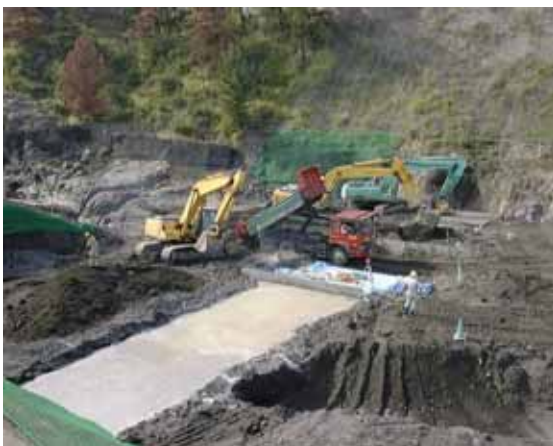
ISM 工法による砂防ダムの施工状況
