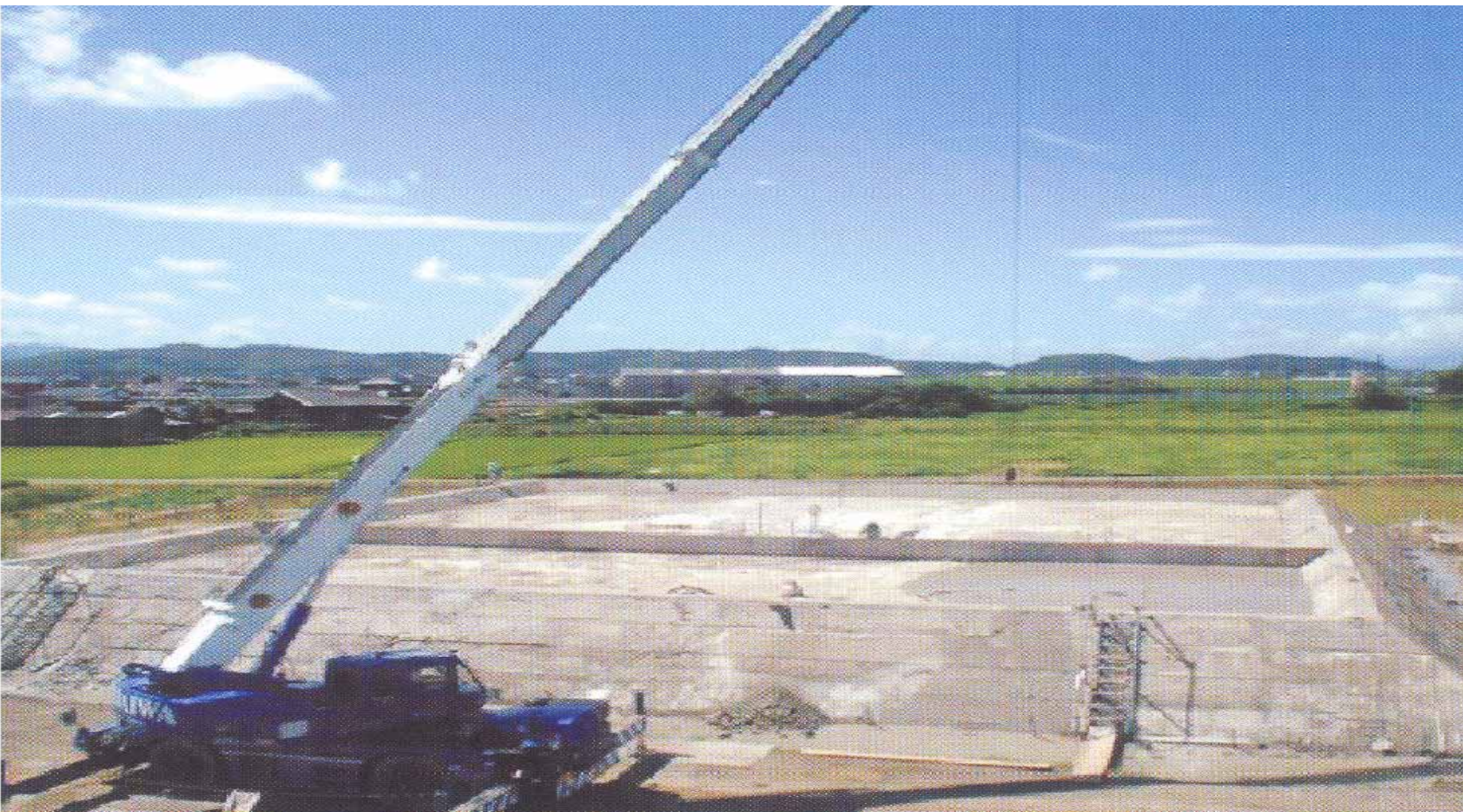
5 段目施工(有明海沿岸道路)
