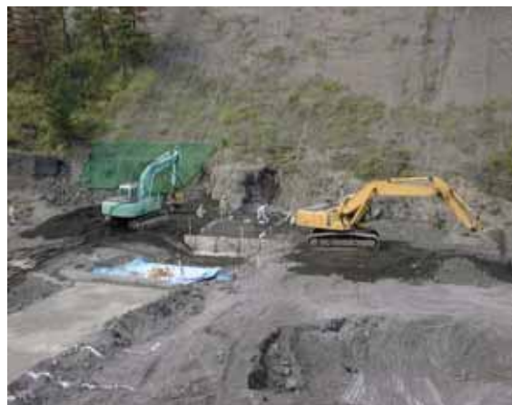
ISM 工法による砂防ダムの施工状況
