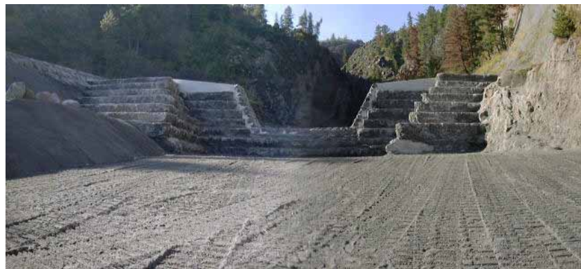
桜島の黒髪第一谷止工（ISM 工法による）
