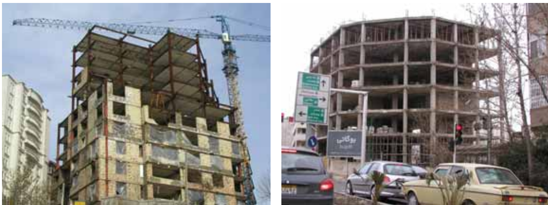
図 3-5-2 テヘラン市内の高層建築工事現場（左：鉄骨造、右：R C造）
