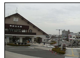
整備された東武日光駅周辺
