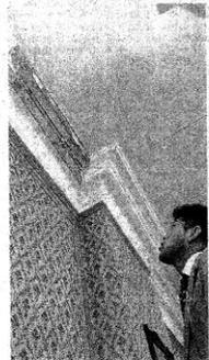
内部では、雨漏りなどが原因で天井の漆喰の一部が剥がれ落ちている（いずれも鳥取市東町で）
