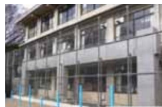
京極小学校:KTB・PCaPC外付けフレーム耐震補強工法
