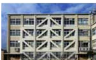
伏見住吉小学校:ピタコラム工法
