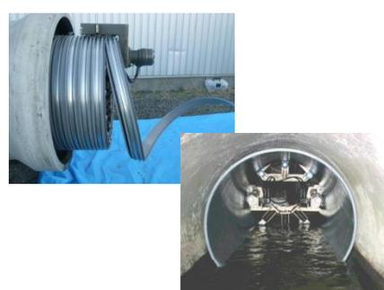
老朽化した管きよの内面をプラスチック材により被覆し再生
