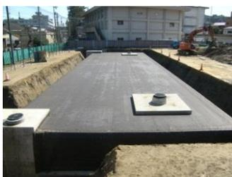
学校のグラウンドの地下に雨水貯留設備を整備(金沢市)
