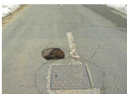
老朽化した管きよに起因する道路陥没
