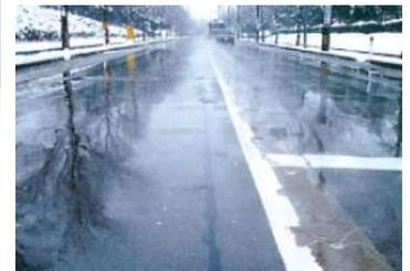
下水処理場からの処理水を利用した道路消雪や、流雪溝による積雪対策(富山県)
