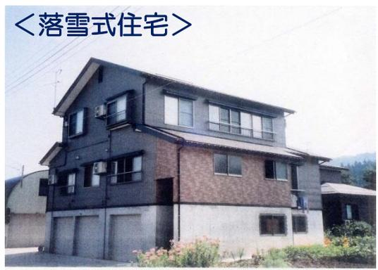
フッ素加工の屋根にあわせて高床式化した自然落雪構造の住宅の新築に対する助成(十日町市・南魚沼市)
