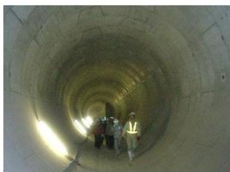
都市の地下に雨水貯留管を整備し、一時的に雨水を貯留し、晴天時に排水(新潟市)
