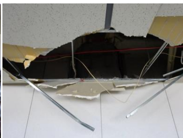
増築部取り合いコンクリート躯体落下
