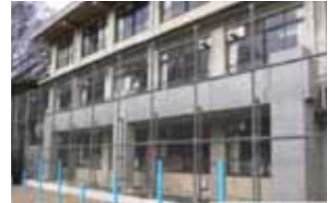
京極小学校:KTB-PCaPC外付けフレーム耐震補強工法
