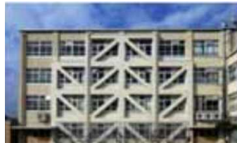
伏見住吉小学校:ピタコラム工法
