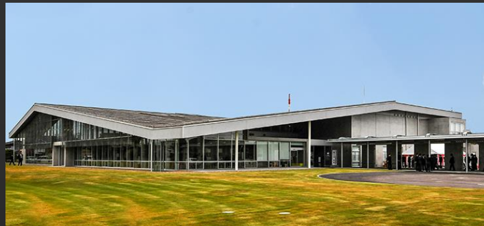
野々市中央地区整備事業（石川県野々市市）
