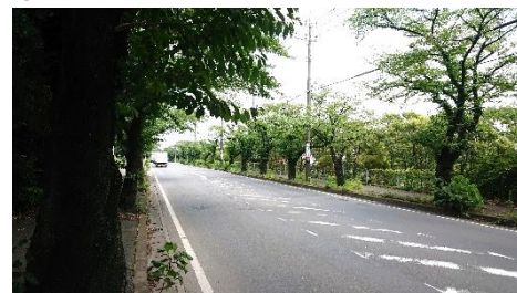
⑥市道 6 号線から北側桜並木を見る
