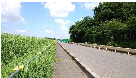
①中央の東西道路から西側を見る 右側はごみ処理施設、左側は土の仮置き場
