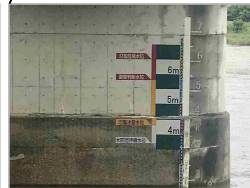
写真：相模大橋橋脚 氾濫危険水位
