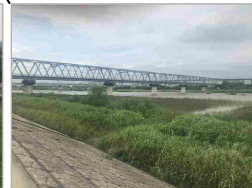
写真：線路橋付近 低水路の雑草繁茂
