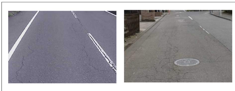
図 4-85. ひび割れの評価指標
