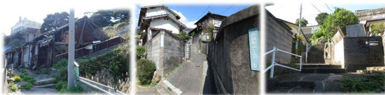
危険な空き家
