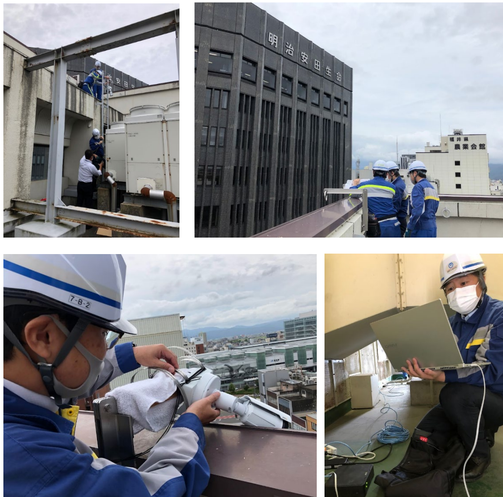
図 4-1-15 社会実験 県庁線側人流調査カメラ設置作業風景
