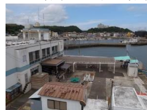
観光センターの浄化槽 等
