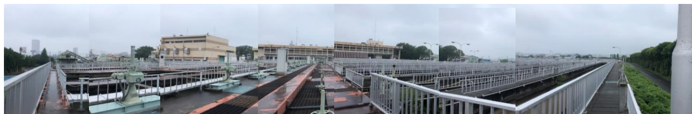
④ 簡易処理施設上部から
