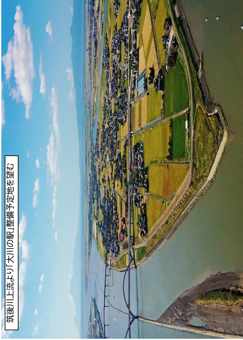
昇開橋上空より「大川の駅」整備予定地を望む
