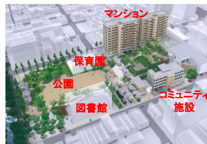
岡山市：出石小学校跡地整備事業
