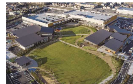
PFI方式を活用した公園整備 (滋賀県大津市)
