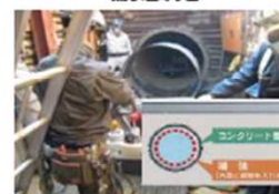
例：管路の耐震補強
