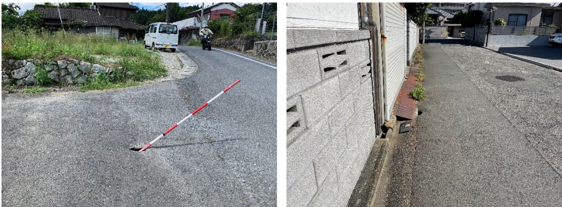
図 4-11 道路の陥没の例
