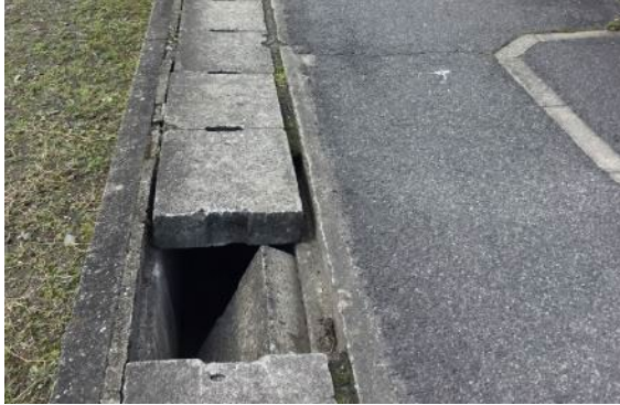
図 4-12 側溝蓋の破損・異常の例
