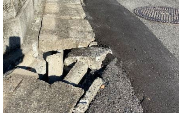
図 4-12 側溝蓋の破損・異常の例
