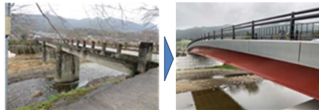
写真1 橋梁架け替え事業での実践例（和東町祝橋）
