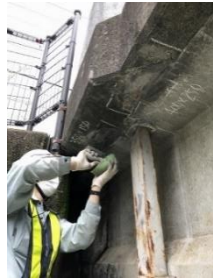
図-5_定期点検時に行う簡易補修の試行的例
