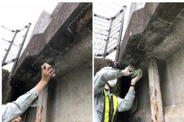
図-6 定期点検時の簡易補修の試行状況
