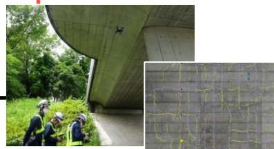
図-6_ドローン×AIを活用したひび割れの進行性の追突例
