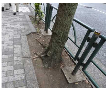
写真 浸透能が低下している街路樹
