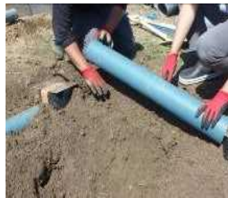
写真 通気透水管の敷設
