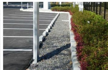
写真 車止め後部に浸透トレンチ敷設
