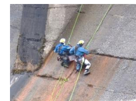
ロープ高所作業
