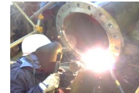
鋼構造物補修
