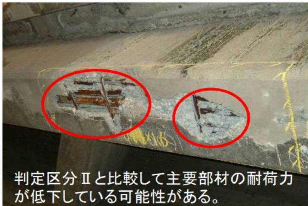
判定区分Ⅲ(主桁の断面欠損)
