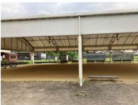
⑤屋根付多目的広場
