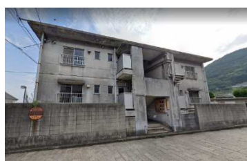
図表 西側拠点の既存建物
