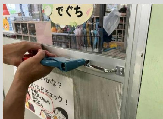
扉の取手取り付け
